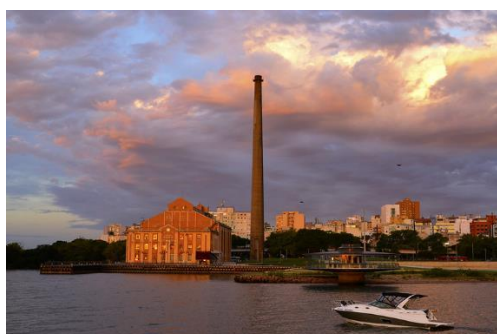
ポルトアレグレ市の旧ガゾメトロ発電所
