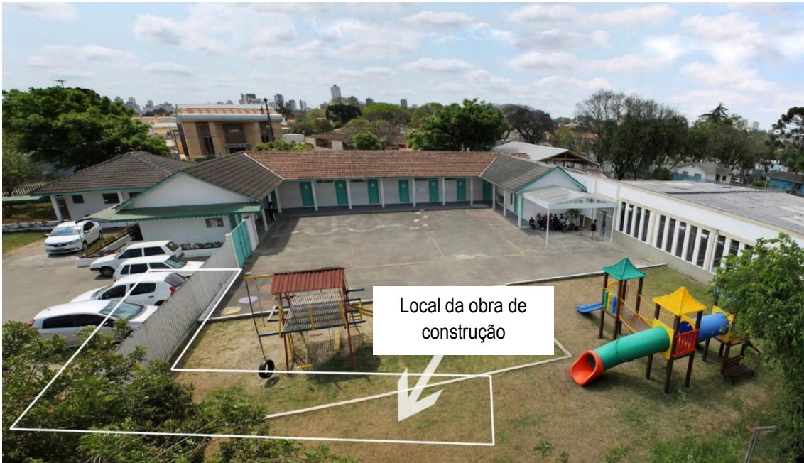
Serão construídas as salas de consultório e aulas (cerca de 130m 2 )
